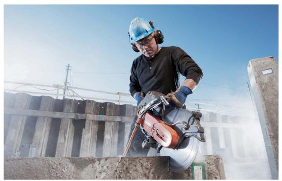
**Plus intelligent.** X-Torq®, le moteur à faibles émissions, accroît la puissance de la découpeuse tout en étant respectueux de l'environnement. La K 760 assure jusqu'à 75 % de baisse des émissions et 20 % de la consommation en carburant, par rapport aux moteurs deux temps conventionnels.
